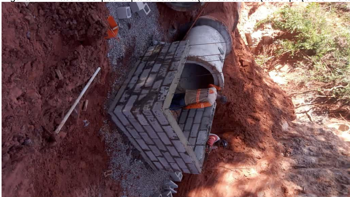
Figura 7 – Lastro de pedra para estabilização da tubulação e poço de visita
