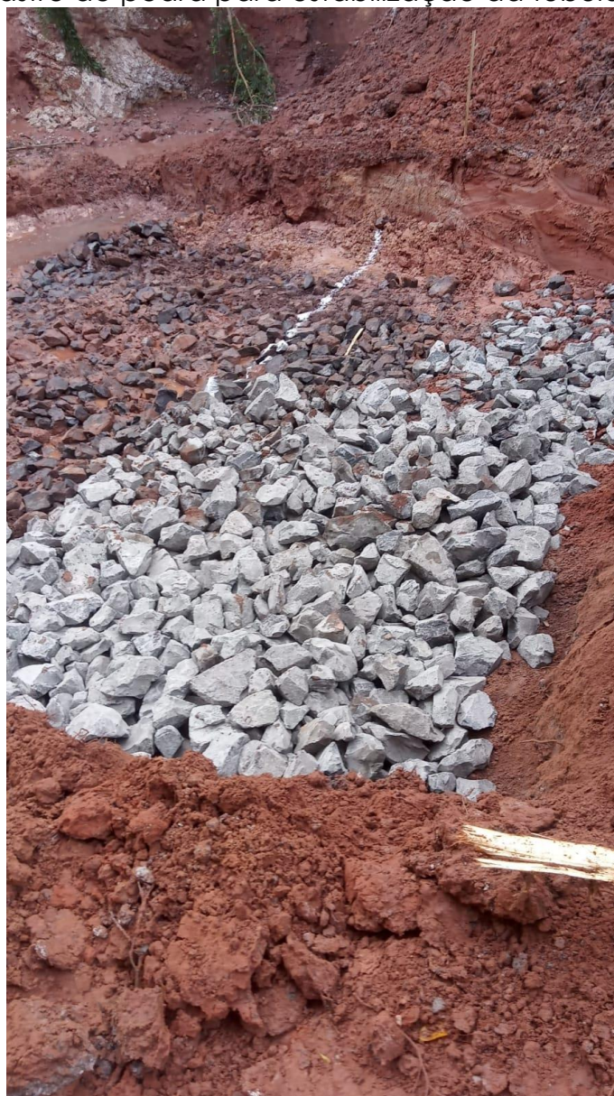
Figura 1 – Lastro de pedra para estabilização da tubulação
