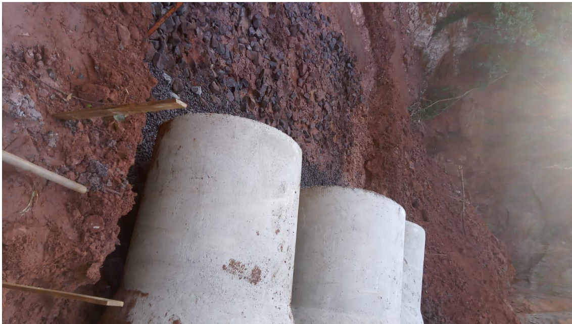
Figura 4 – Lastro de pedra para estabilização da tubulação
