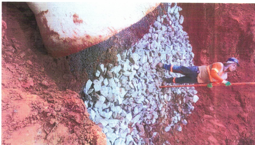
Figura 3 – Lastro de pedra para estabilização da tubulação
