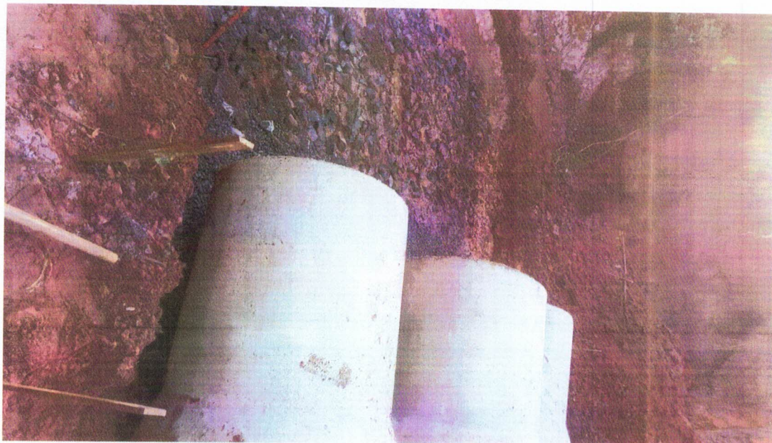
Figura 4 – Lastro de pedra para estabilização da tubulação
