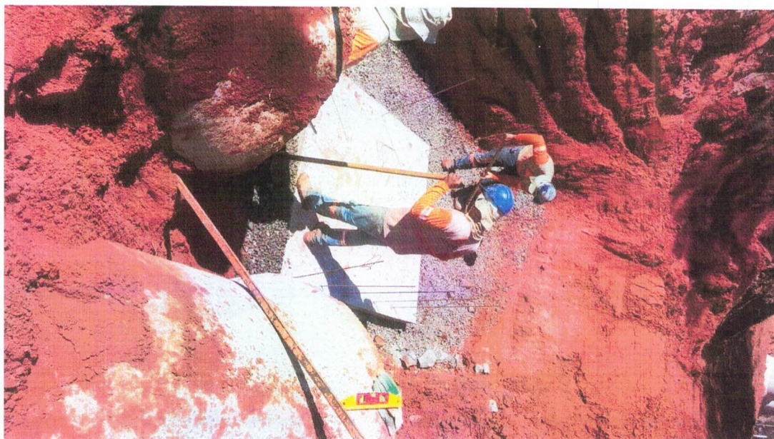
Figura 5 – Lastro de pedra para estabilização da tubulação e poço de visita
