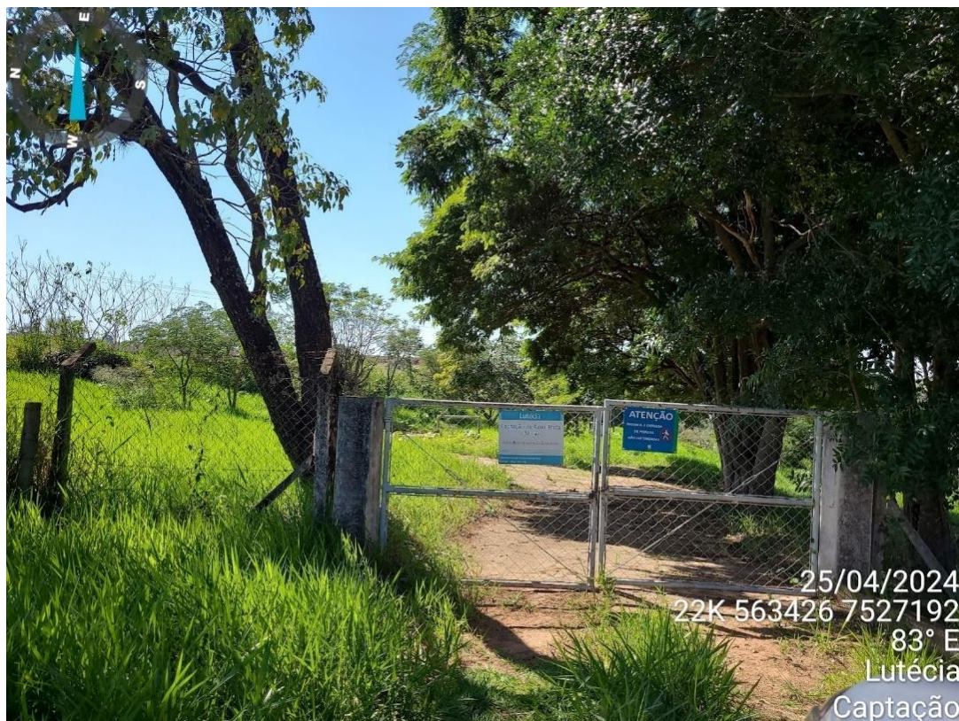
Figura 68 - Entrada para o setor de captação de água subterrânea do município
