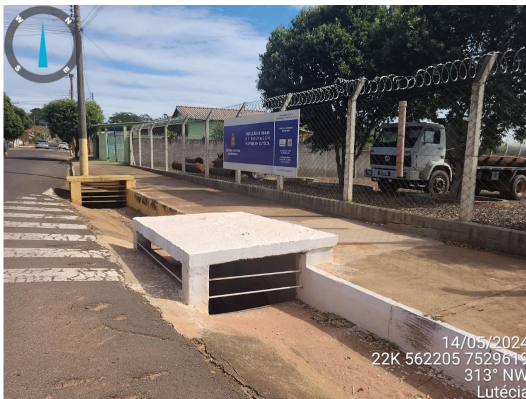
Figura 76 - Obra de Drenagem concluída no Município de Lutécia 2024
