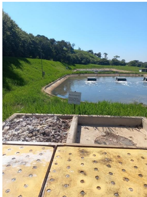
Figura 74 - Início do tratamento na ETE
