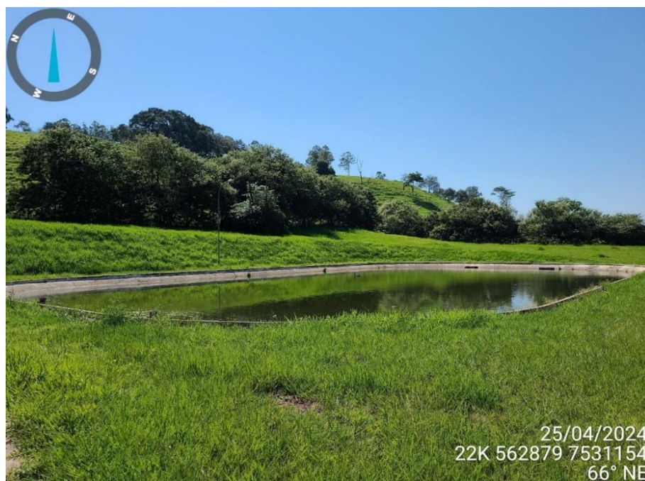
Figura 73 - Lagoa de estabilização da Estação de Tratamento de Efluente da SABESP
