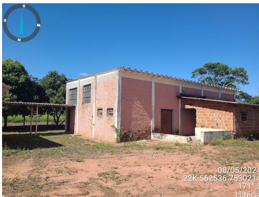
Figura 78 - Galpão onde era realizada triagem e armazenamento de recicláveis
